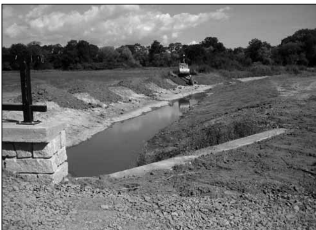
Hloubení a tvarování meandrujícího koryta Bílovky (Foto Helena Musilová).
