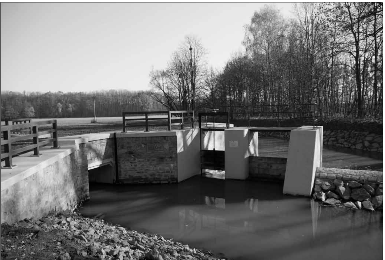
Rozdělovací objekt – vpravo je nátok a přeliv do regulované Bílovky, vlevo teče voda do revitalizované Bílovky (Foto Radim Jarošek).
